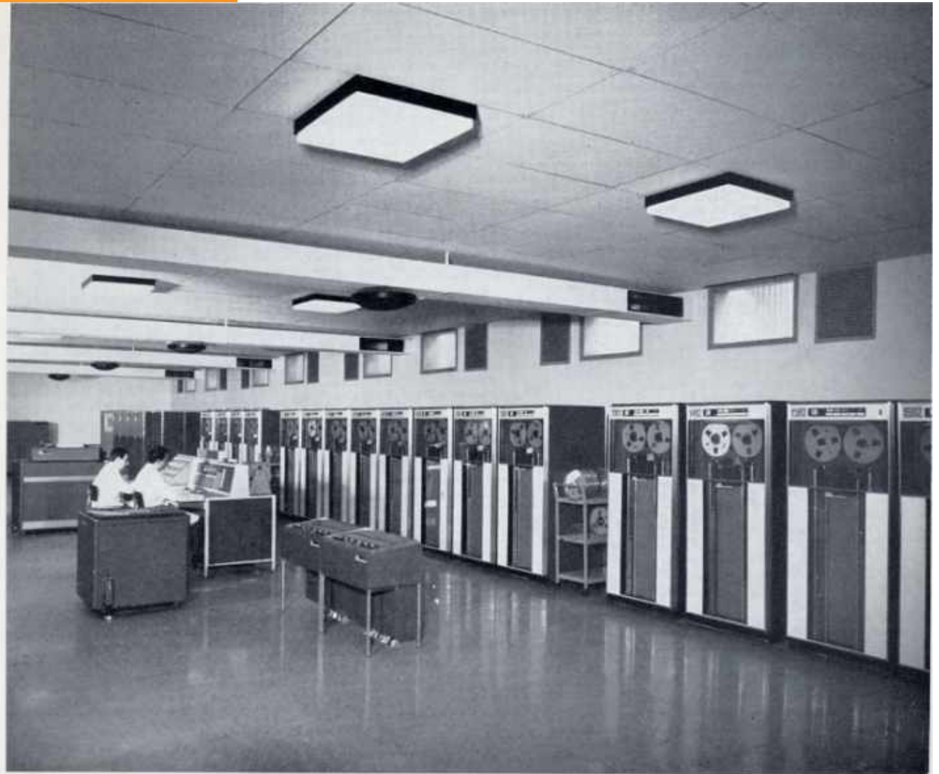
Fig. 5 - Sala del sistema accoppiato IBM-7094-7040. Sala del sistema 7094
