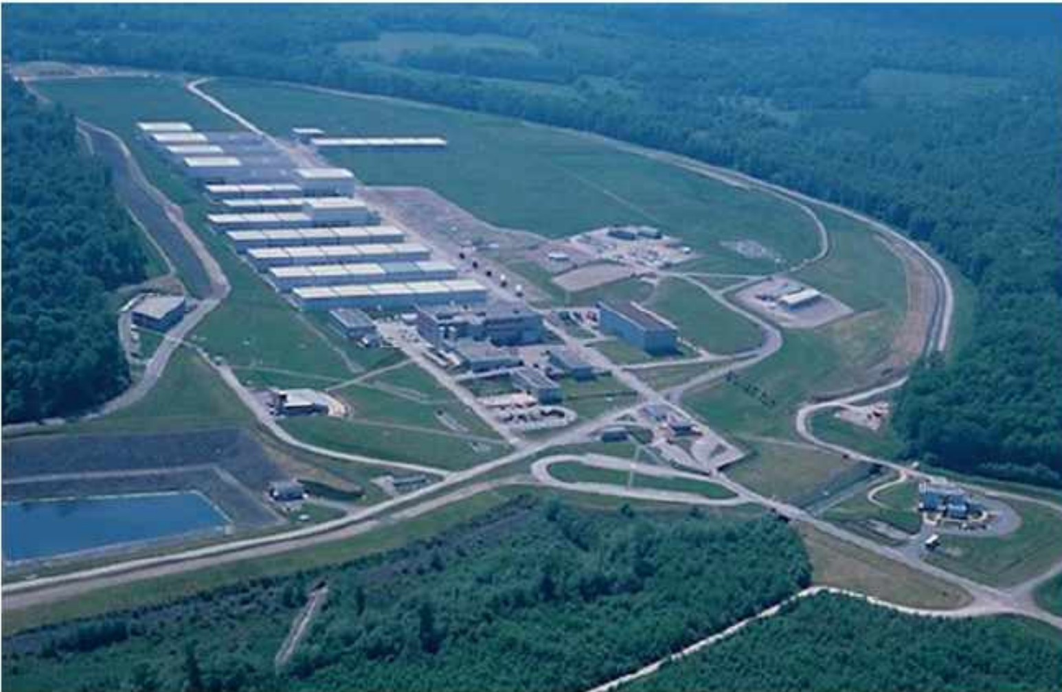
Fig. 11 - Deposito definitivo per materiali a bassa e media attività (L'Aube, Francia, capacità un milione di m 3 ).
